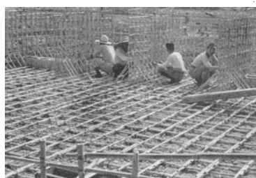
ストラップのない梁の平竹筋配筋
