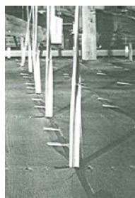
天井板の竹の吊り木(桂離宮古書院)
