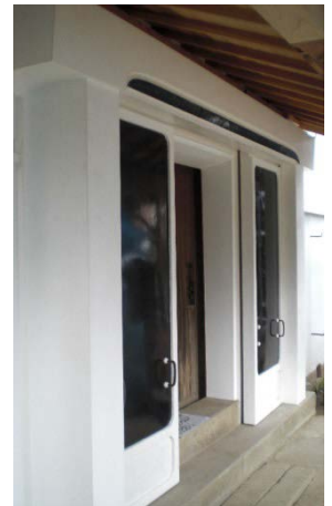
▲真壁町の土蔵の改修例
