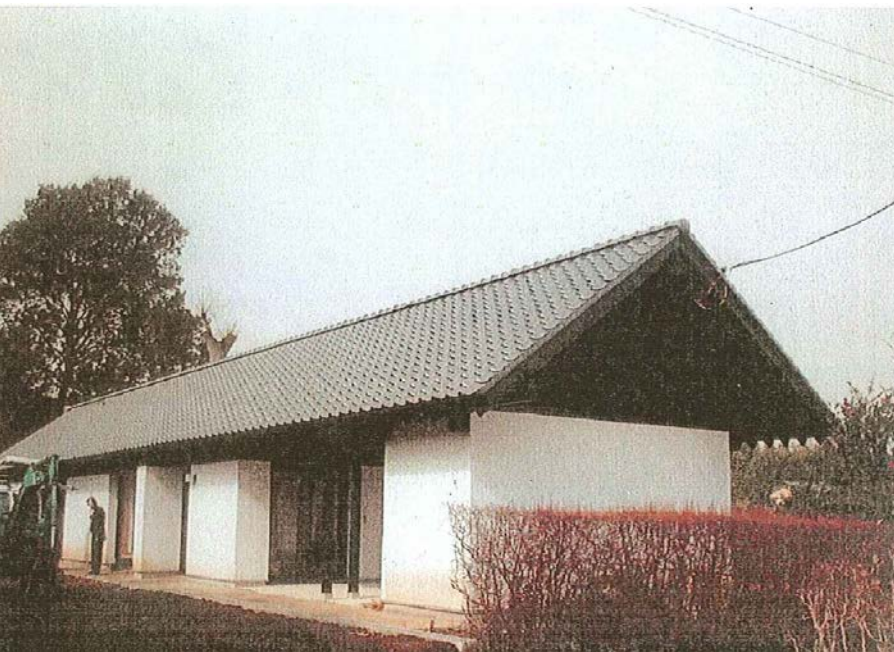
●完成真近の外観と内部の様子。壁は内外とも漆喰左官仕上げ、松材の梁と桁を伝統的な継ぎ手、仕口で組み上げた。
