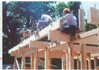
上棟時の梁と桁の「渡りあご工法」の様子。
