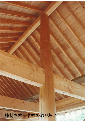
●完成真近の外観と内部の様子。壁は内外とも漆喰左官仕上げ、松材の梁と桁を伝統的な継ぎ手、仕口で組み上げた。
